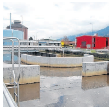
In den Reinigungsbecken verrichten Bakterien die Hauptarbeit
