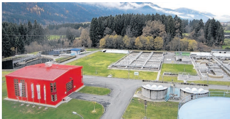
Die Verbandskläranlage Spittal von oben bzw. den Faultürmen aus gesehen
